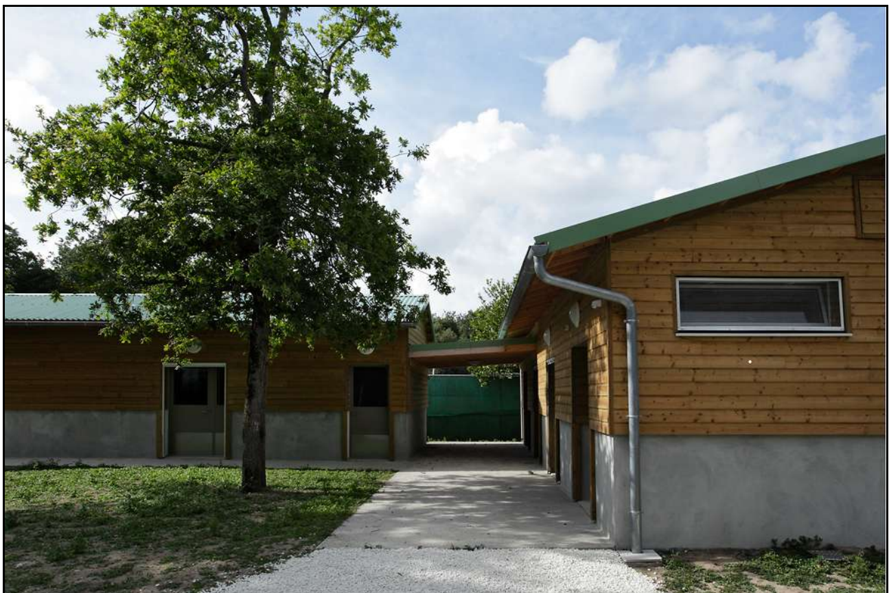
Avancement des travaux au 22.06.2012
