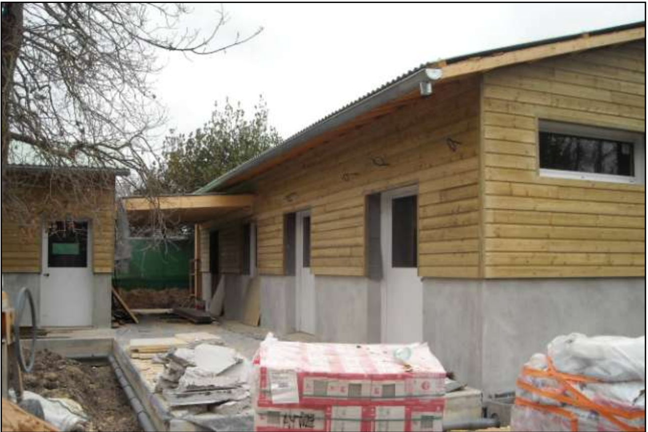
Avancement des travaux au 13.01.2012
