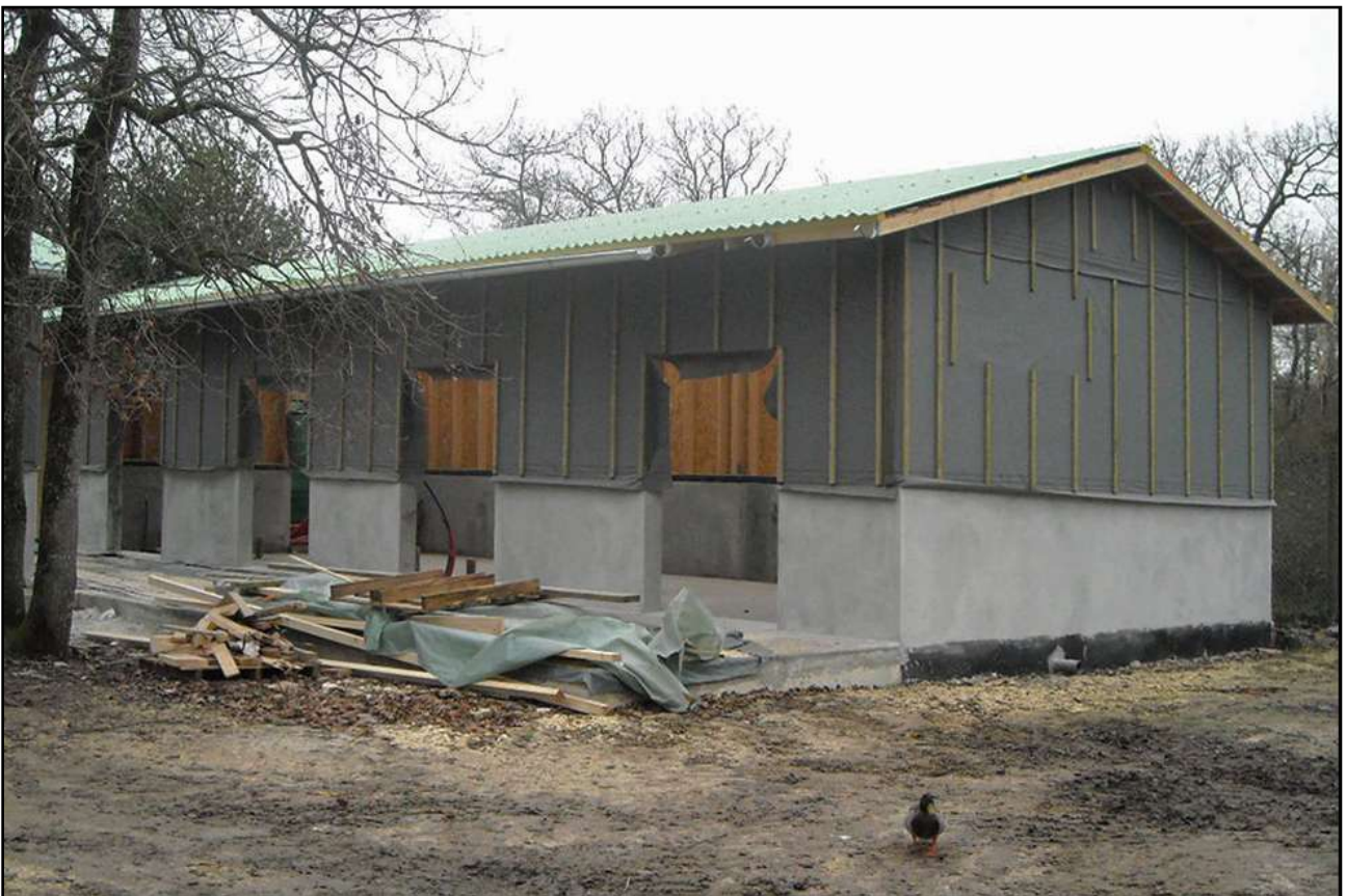
Avancement des travaux au 29.11.2011
