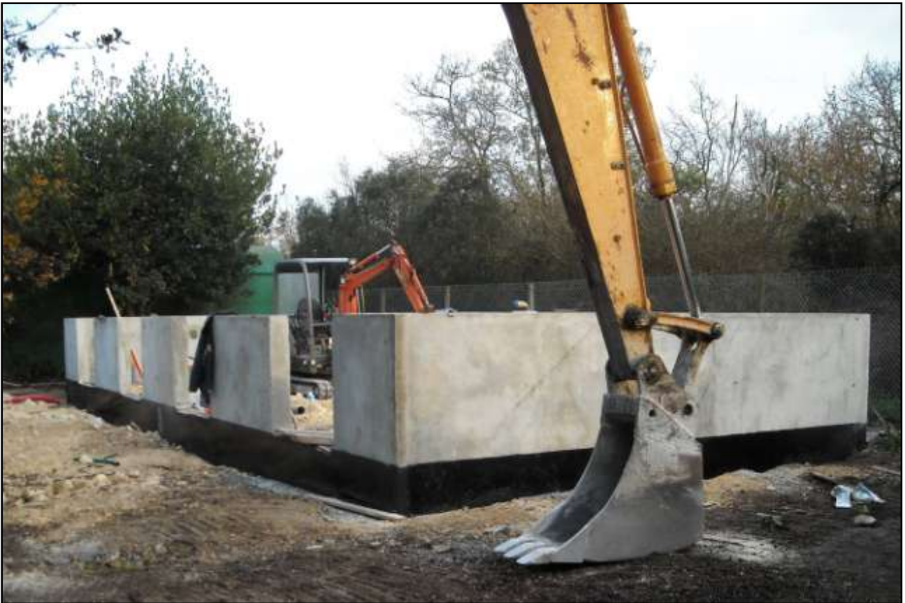
Avancement des travaux au 12.11.2011
